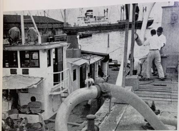
← 船舶給水作業
