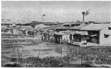
照片一——聚集於臭水池塘岸旁之違建——忠貞里
