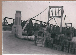
15. 建設中の栄橋
